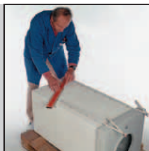
Maßübertragung auf den Stülpkopf
