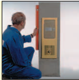
1.2 Fertigfuß in Mörtel versetzen und lotrecht ausrichten
