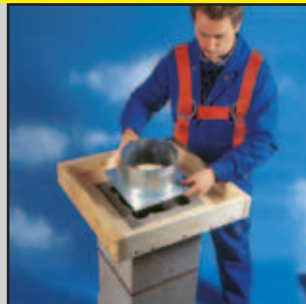
14.2 Variante: Bei Ortbetonabdeckplatten das Schiedel Schalblech verwenden! (Separat anfordern!)
