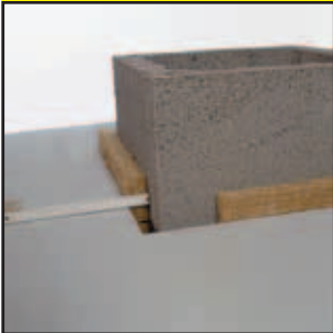
12.1 Deckenaussparung allseitig 3cm größer als Mantelsteinmaß
