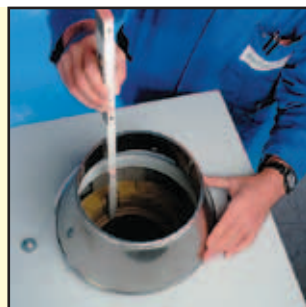
5.6 Fehlende Rohrlänge ausmessen
