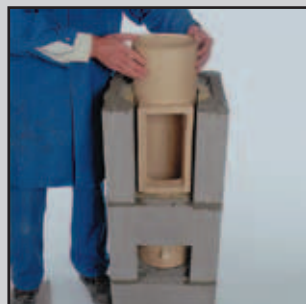
9.2 PA-Formstück versetzen, Zargenabstand planparallel zum Mantelstein
