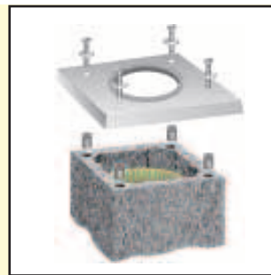
5.3 Mörtelbett auftragen, Abdeckplatte auflegen und verschrauben
