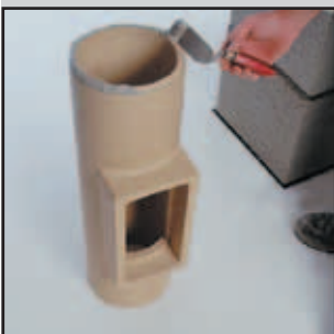
9.1 Fugenkitt auf Unterseite Putztüranschluß-Formstück (PA) auftragen
