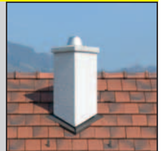
14.4 Variante: Schiedel Kaminkopf aus Faserbeton
