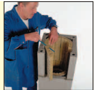
2.4 Vordere Hinterlüftungszellen freilassen, dazu Matten kürzen
