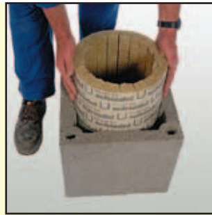
3.7 Dämmplatten gemeinsam nach unten schieben
