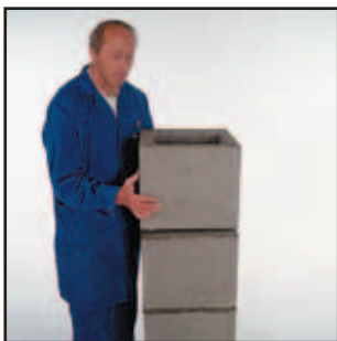
4.1 Mantelstein in Mörtel versetzen
