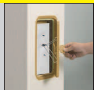
11.4 Transportsicherung beim Innendeckel entfernen, Innendeckel einsetzen. Äußeres Türblatt einhängen und schließen
