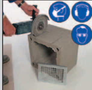
6.2 Öffnung für Zuluftgitter herstellen
