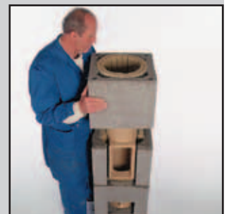
9.4 Vorgeädämten Mantelstein versetzen
