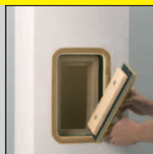
11.3 Nach Erhärten des Putzes Innendeckel in Schamottezarge einstecken
