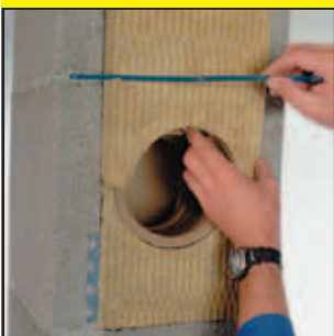
10.1 Frontplatte zuschneiden
