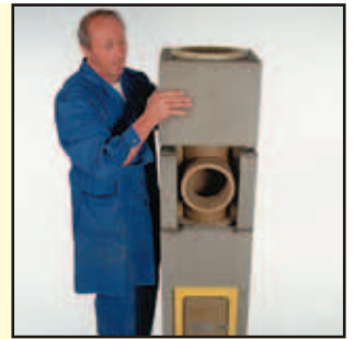
3.8 Vorgeädmmten Mantelstein versetzen
