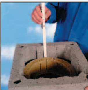
5.1 Dämmplatten enden 8cm unter dem obersten Mantelstein
