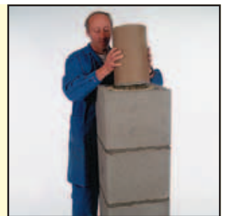
4.4 Schamottrohr versetzen, Versetzvorgang bis zur Mündung wiederholen
