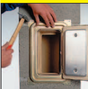
11.1 Türblatt aushängen und Rahmen zentrisch zur Schamottezarge am Mantelstein annageln
