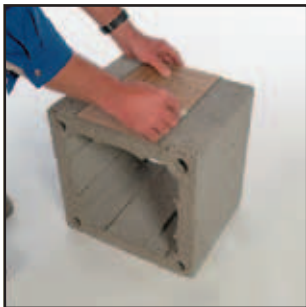
2.1 Mantelstein mit Anreißschaablone anzeichnen, Schaablone mittig anlegen
