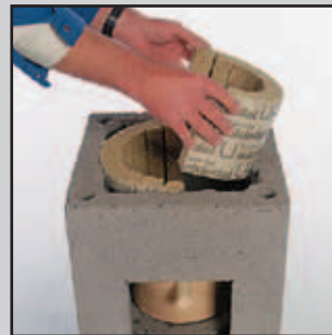
7.3 Gegenhälfte einsetzen, Stoßfugen nicht im Bereich der Hinterlüftung!
