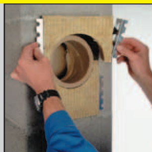
10.2 Haltewinkel aufstecken und mit Frontplatte einsetzen
