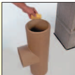
3.2 Unterseite des Rauchrohranschluß-Formstückes säubern
