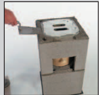
7.4 Mörtel auftragen - Schablone verwenden!
