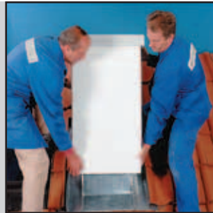
13.2 Stülpkopf versetzen, lotrecht ausrichten
