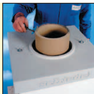
5.10 Schamottrohr einsetzen und auf Oberseite Fugenkitt auftragen
