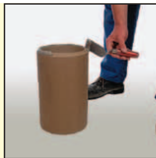
4.3 Fugenkitt auf Rohrunterseite auftragen
