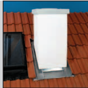
13.3 Seitliche Stellschrauben bis zum Mantelstein drehen
