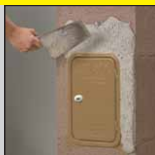
11.2 Nach Einhängen des Türblattes, Rahmen einputzen. Generell von Vorteil: zusätzliche Putzbewehrung
