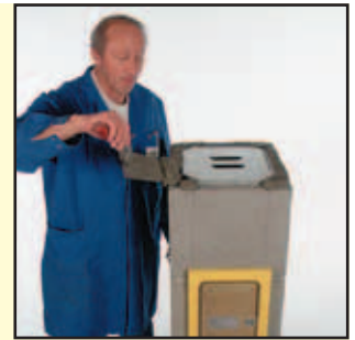
1.4 Mörtel mit Versetzschaablone auf Fertigfuß auftragen
