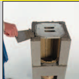
8.3 Mörtel aufbringen, Schablone verwenden
