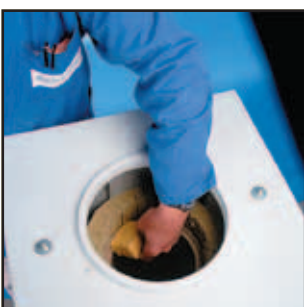
5.9 Rohraufstandsfläche säubern, Fugenkitt auftragen
