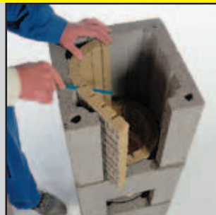
8.2 Dämmplatten einbringen und kürzen, Hinterlüftungszellen bleiben frei
