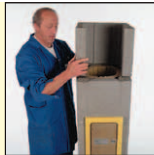
2.3 Öffnungsstein in Mörtel versetzen, Dämmplatten biegen und einsetzen
