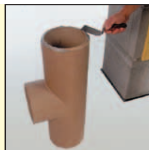
3.3 Fugenkitt auf Rohrunterseite auftragen
