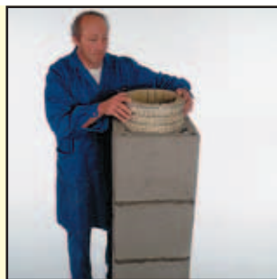
4.2 Dämmplatten biegen, einsetzen und gemeinsam nach unten schieben
