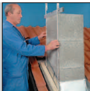
Ermittlung des Schrägschnittes
