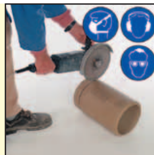
5.7 Schamottrohr zuschneiden
