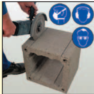
2.2 Mit Winkelschleifer Öffnung herstellen
