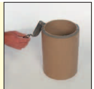
5.8 Fugenkitt auftragen
