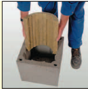
3.6 Dämmplatten biegen und einsetzen
