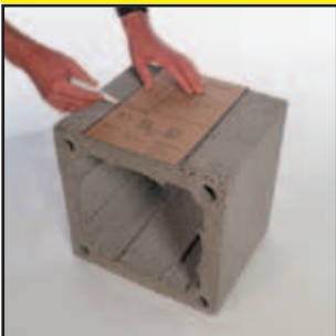
8.1 Mantelstein mit Schablone anzeichnen und ausschneiden
