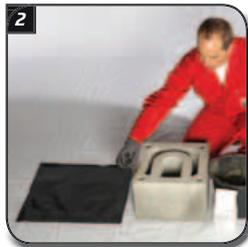
**Feuchtigkeitssperre** und satte Mörtelschicht über Fundament anbringen (z.B. Mörtel – Dachpappe – Mörtel).
