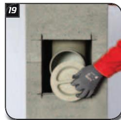
**Runde Putztür** einsetzen. (Zum Öffnen und zum Schließen immer rechts drehen)
