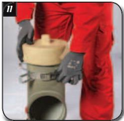
**Abstandhalter (Ring)** unter der Muffe unter dem Putztürstutzen des Putztürformstücks anbringen.
