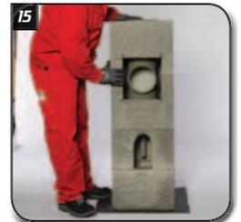
Auf **Ausrichtung** des Putztürformstücks zur Öffnung des Mantelsteinverschlusses achten.
