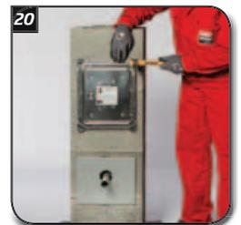
**Mantelsteinverschluss** dicht zum Mantelstein einbauen.
