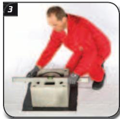
**LAF Anfangsstein 1** (für Zulufführung bis Unterkante Kamin) mit Mörtelschicht auf Feuchtigkeitssperre aufsetzen und ausrichten.
