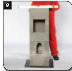
**Mantelsteine** in Dünnbettmörtel setzen und ausrichten.
