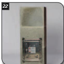
**Nächsten Mantelstein** versetzen und ausrichten.
