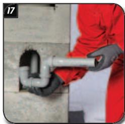
HT-Ablaufrohr bzw. Schlauch (optional) auf den **Stutzen der Kondensatauffangschale** schieben.
