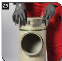
Bei jedem zu versetzenden Edelkeramikrohr ist ein **Abstandhalter auf Muffe Oberkante** zu befestigen.
