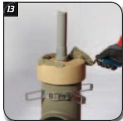
**Tipp:** Um die Dichtheit der Raumluft zu erhöhen, kann eine satte Mörtelschicht an der Unterseite der Kondensatauffangschale aufgetragen werden.
