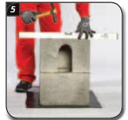
**LAF Anfangsstein 2** (für Zulufführung bis Unterkante Kamin) auf Mantelstein aufsetzen und ausrichten.
