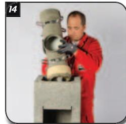
**Putztürformstück** mit der Kondensatauffangschale einsetzen.
