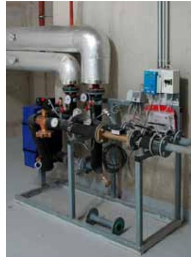
für Verbraucher mit gleichmäßigem Warmwasserbedarf geeignet, da das benötigte Wasser direkt an der Übergabestation, ähnlich eines Durchlauferhitzers, erwärmt wird. Für Einfamilienhäuser, die in der Regel über einen schwankenden Warmwasserbedarf verfügen, ist das Speichersystem besser geeignet. Hierbei kann der Fernwärmeanschluss kleiner ausgelegt werden, da das Wasser innerhalb eines Speichers erwärmt wird und bei Bedarf entnommen werden kann.
