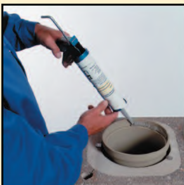
4.2 RAPID-fugendicht satt auftragen
