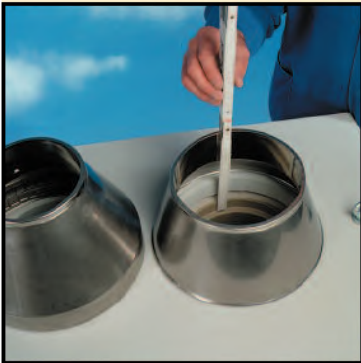
5.1 Abströmkonus aufsetzen, fehlende Rohrlänge ausmessen
