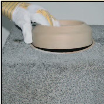
2.3 Adapterring einsetzen
