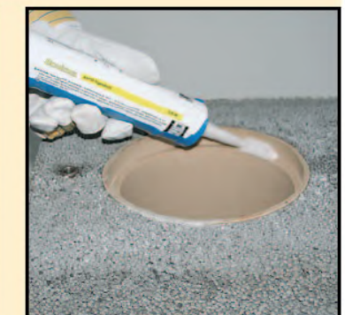
2.2 RAPID-fugendicht satt auftragen
