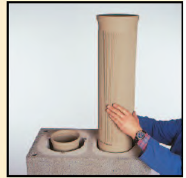
3.8 Profiltröhr (1,33 m) für den zweiten Kaminzug einsetzen
