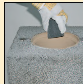
2.1 Steckverbindung säubern
