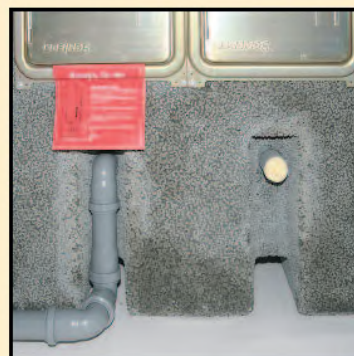
1.1 Mörtelbett MG (M5) IIa bzw. MG (M2,5) II vorbereiten, Feuchtesperre einlegen - 1.2 weites Mörtelbett MG (M5) IIa bzw. MG (M2,5) II auftragen und Fertigfuß versetzen
