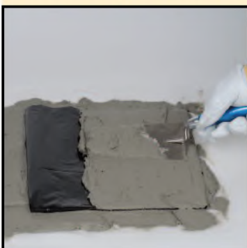
1.1 Mörtelbett MG (M5) IIa bzw. MG (M2,5) II vorbereiten, Feuchtesperre einlegen - 1.2 weites Mörtelbett MG (M5) IIa bzw. MG (M2,5) II auftragen und Fertigfuß versetzen
