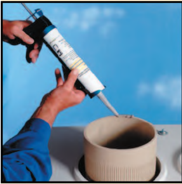
5.5 Rohr einsetzen, glattes Rohrende zeigt nach oben, RAPID-fugendicht auftragen
