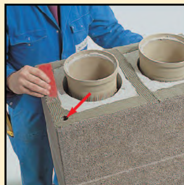
4.3 Dünnbettmörtel auftragen, Eckkanäle bleiben frei
