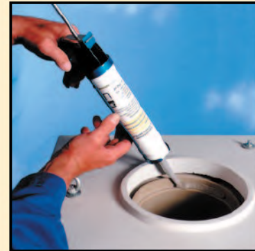
5.4 RAPID-fugendicht auftragen
