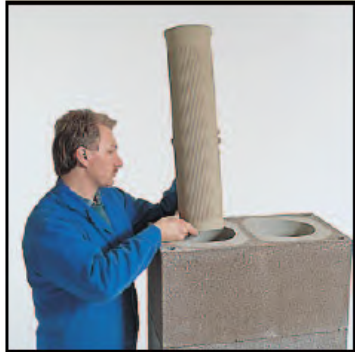
3.1 Profiltröhr L= 66 cm versetzen (aus dem RA-Paket entnehmen)
