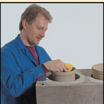
4.1 Steckverbindung säubern
