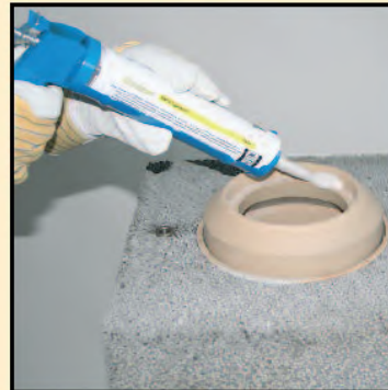
2.4 RAPID-fugendicht satt auf Adapterring auftragen
