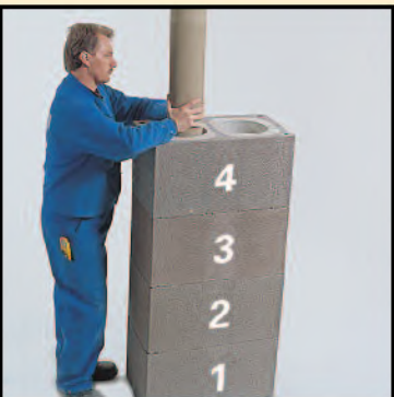
4.5 Profilrohr L=1,33 m einsetzen
