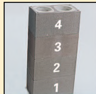
4.4 Vier Mantelsteine jeweils in Dünnbettmörtel versetzen
