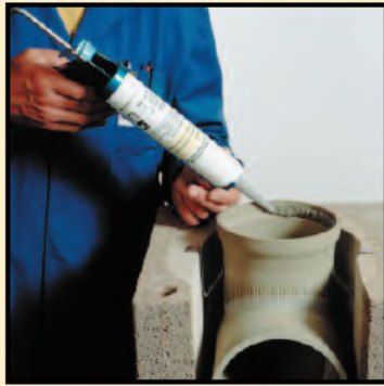
3.6 RAPID-fugendicht im Bereich der Steckverbindung satt auftragen
