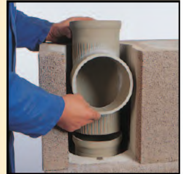
3.4 Rauchrohranschluss einsetzen L= 33 cm bis Ø14 cm L= 66 cm Ø16 -20 cm
