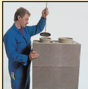
4.7 RAPID-fugendicht-Reste mit Fugenglätter abstreifen. Standard-Versetzvorgang bis zur Mündung wiederholen.
