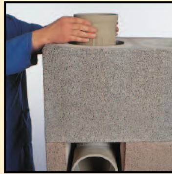
3.7 Nächsten Mantelstein versetzen und 0,33 m Profiltröhr einsetzen
