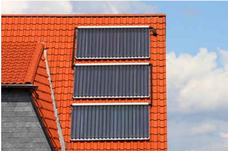
hierzu direkt auf den Sparren, bzw. auf die Verlattung aufgebracht – eine zusätzliche Dacheindeckung entfällt also. Eine Montagevariante, die sich allerdings nur für Schrägdächer, aufgrund des schlechten Neigungswinkels nicht für Flachdächer eignet. Neben den optischen Vorzügen bietet die Indachlösung einer Solarthermieanlage aber auch thermische Vorteile. Durch die bündige Verlegung der Kollektoren wird dem Wind die Angriffsfläche genommen, der Wärmeverlust ist demnach geringer, als bei einer
