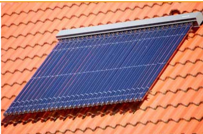
Solarthermieanlage mit einer Größe von rund 1,5 Quadratmeter pro Person und einem Speicher mit circa 400 Litern Inhalt im Jahresdurchschnitt rund drei Fünftel des Bedarfs an warmem Wasser decken.
